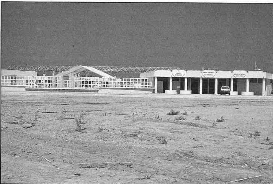
● Les locaux de l'Union, de la Police et du Contrôle, vues de l'intérieur du quartier naturiste.
